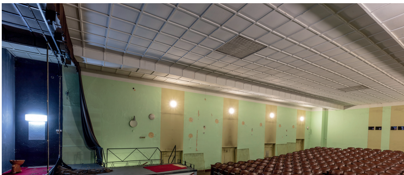
Wnętrze sali kinowej w dawnym kościele ewangelickim w Nowym Mieście Lubawskim, stan przed przystąpieniem do prac rozbiórkowych.
