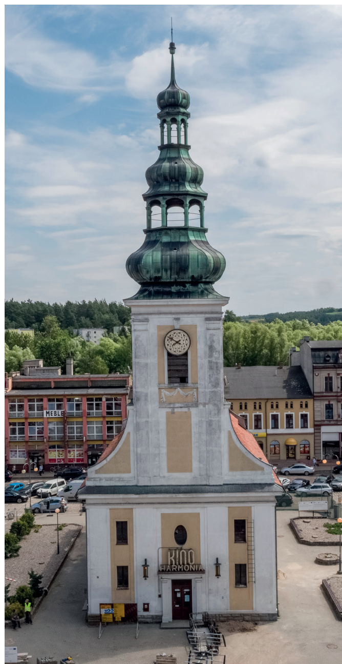
Dawny kościół poewangelicki w Nowym Mieście Lubawskim, elewacja zachodnia, stan przed pracami konserwatorskimi w 2019 roku.
