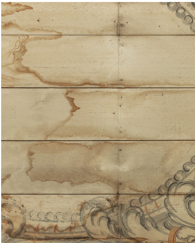
Dekorowany strop w dawnym kościele ewangelickim w Nowym Mieście Lubawskim, fragmenty obrazujące stan zachowania i zakres zniszczeń.
