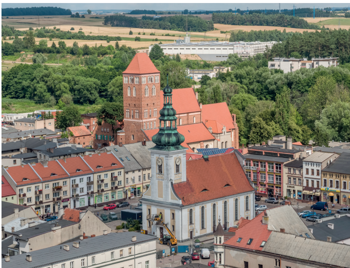
Dawny kościół poewangelicki w Nowym Mieście Lubawskim, widok od południowo-zachodu, stan przed pracami konserwatorskimi w 2019 roku.
